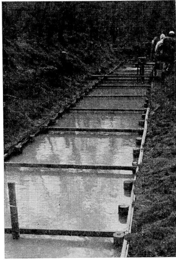
図2-4-55 三里浜砂丘の涵養水路
