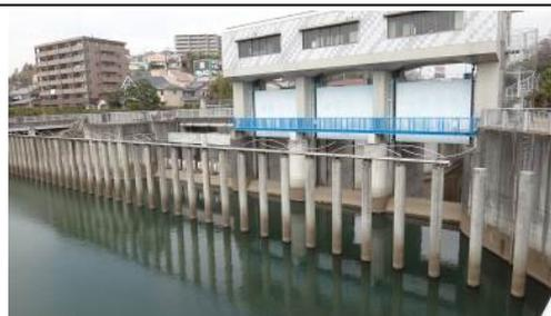
この分水路は長さ5.3kmのトンネル(高さ9.0m、幅11.2mで新幹線のトンネルより大きな断面)で横浜国大、三ツ沢公園の下を通り抜け、横浜駅北方の鶴屋町を経て東京湾に繋がります。
