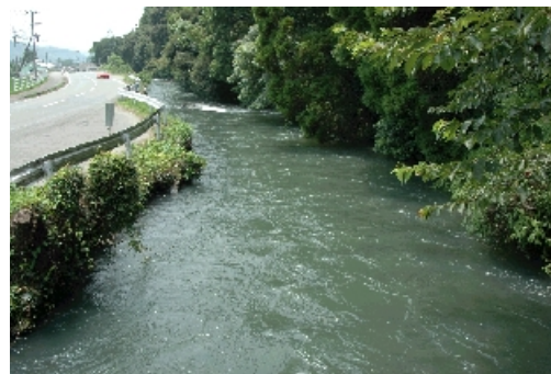
写真3 加藤清正の時代頃の構築とされるかんがい水路。この用水が水田を通して地下水となる
