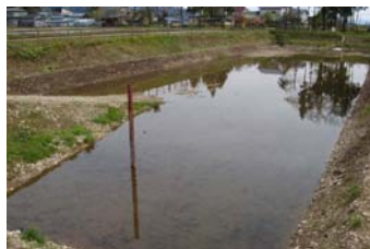
地下水涵養池
