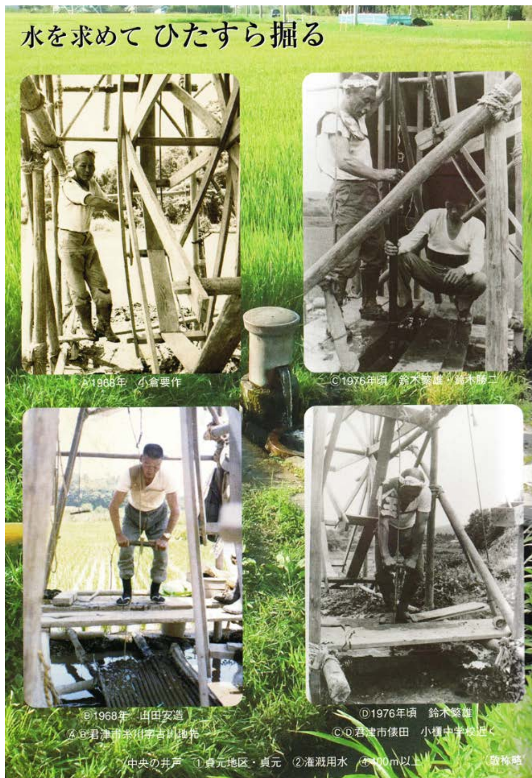
図 5-5-2 上総掘りの作業風景（上総掘りを記録する会、2011）
