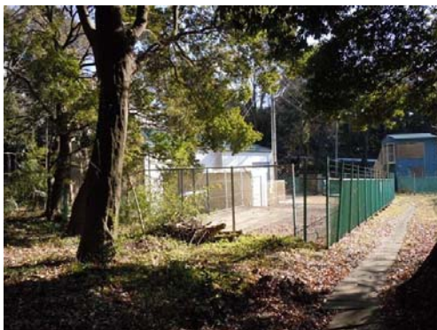
写真4 第1水源地の建屋
